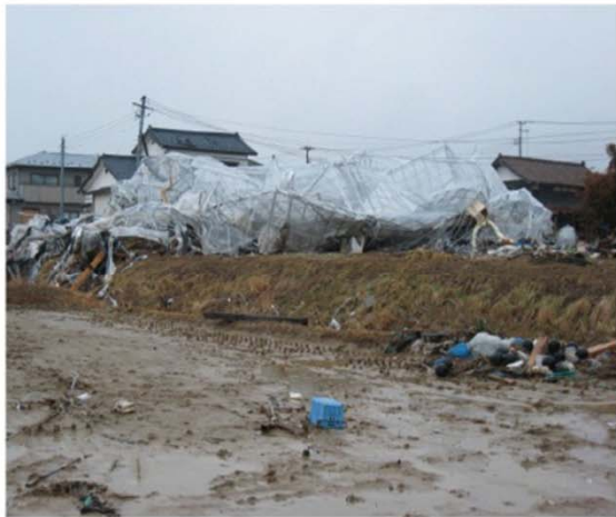
栽培設備の被害状況 2
